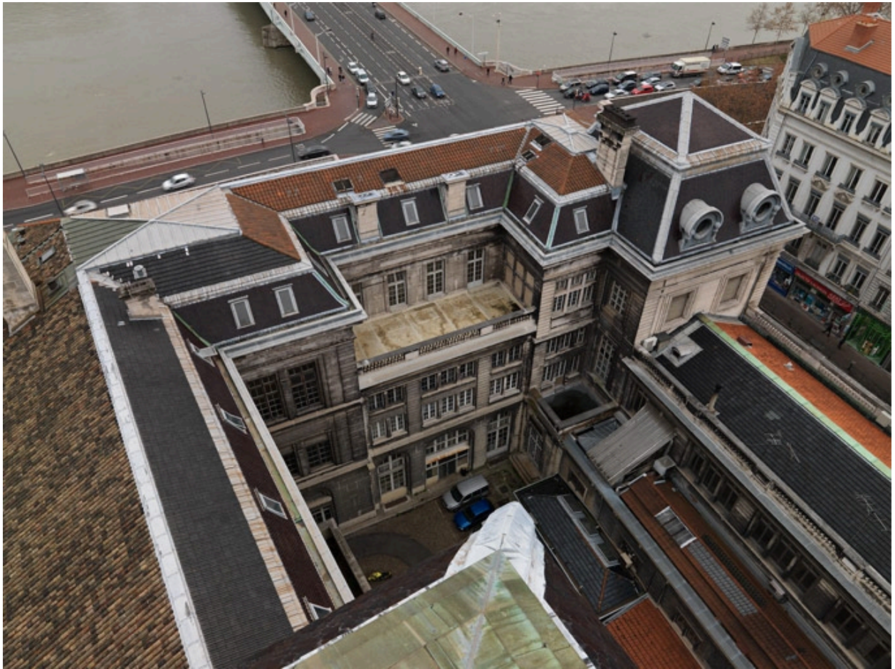
Bâtiment A. Vue depuis le dôme Pascalon à l'ouest
