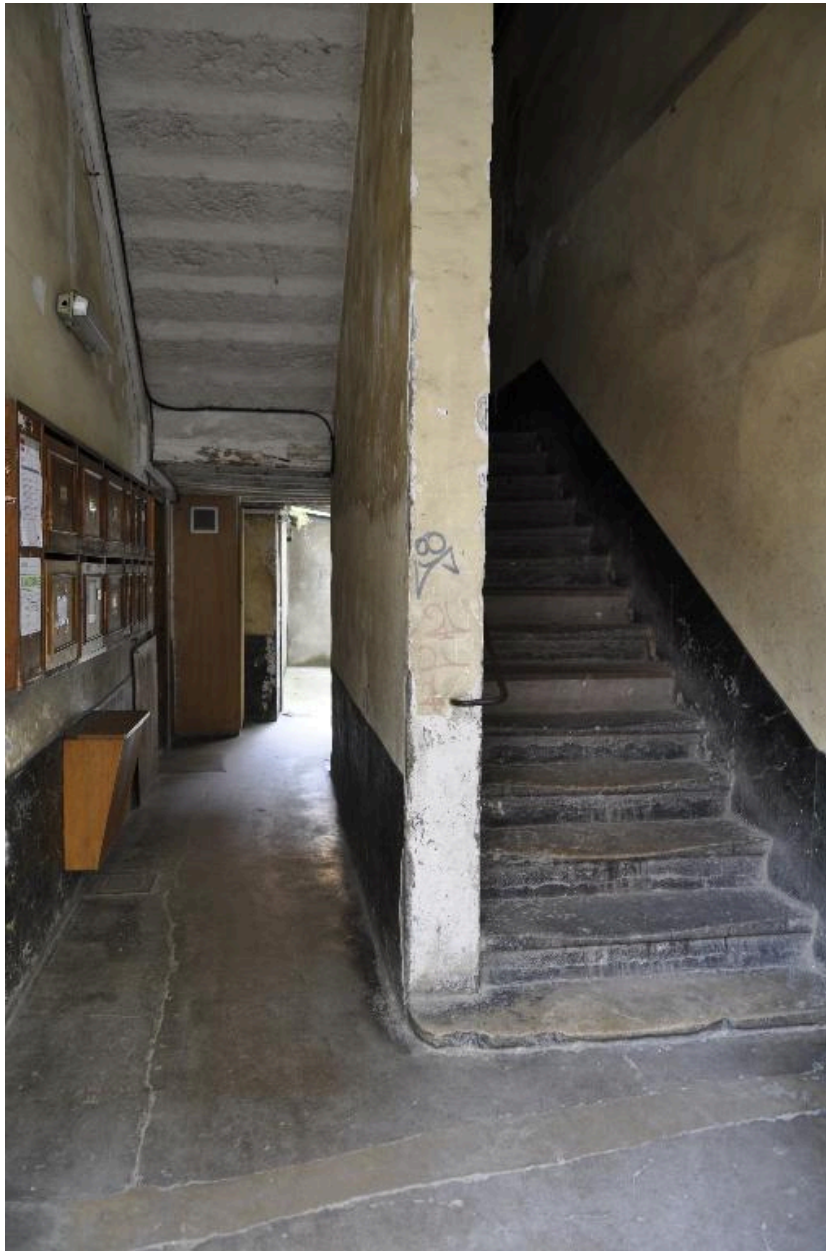
Départ de l'escalier du n°1 rue Dumenge commun avec le n°3
