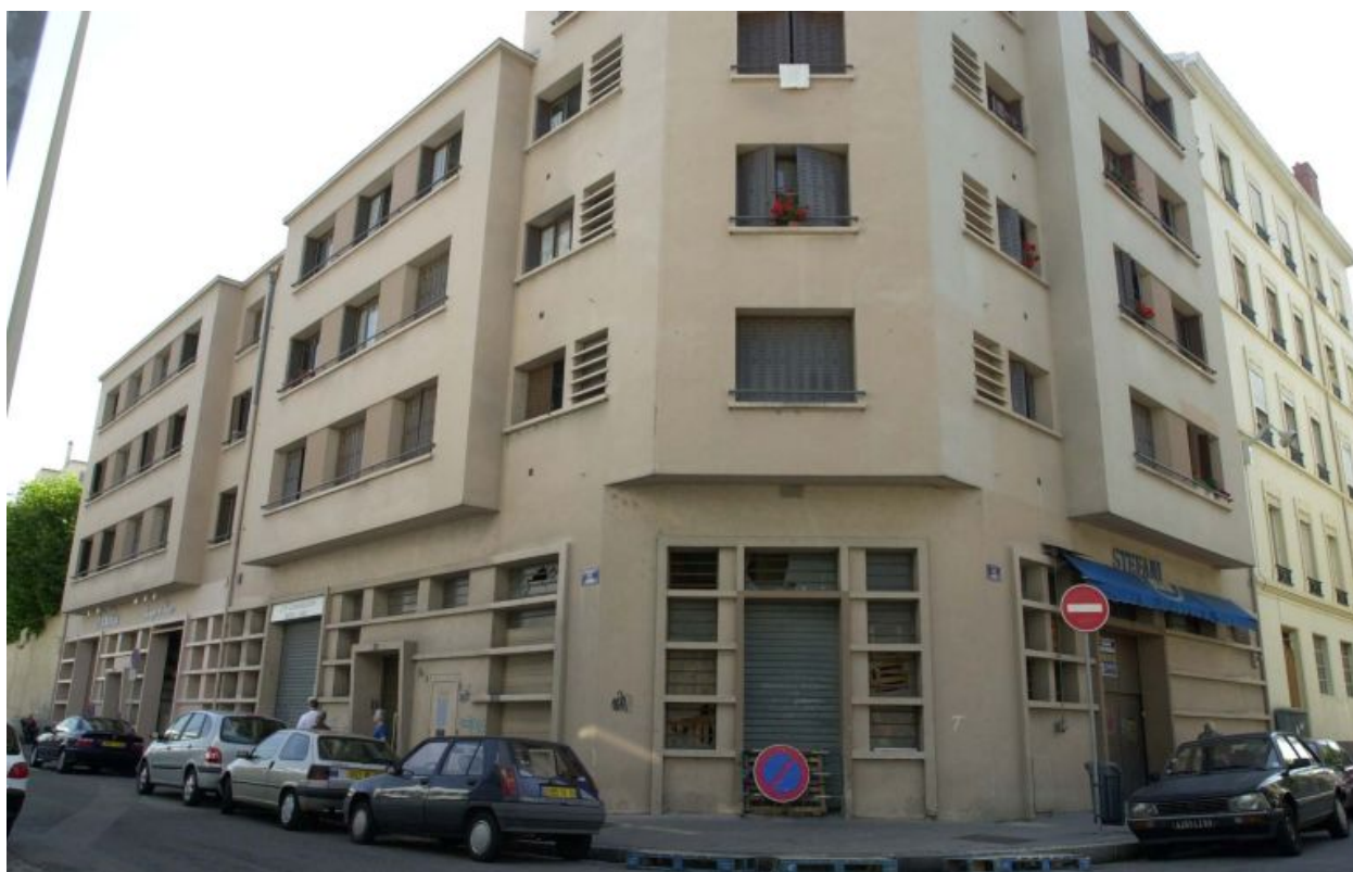
Vue d'ensemble du rez-de-chaussée, à l'angle des rues Seguin et Ravat
