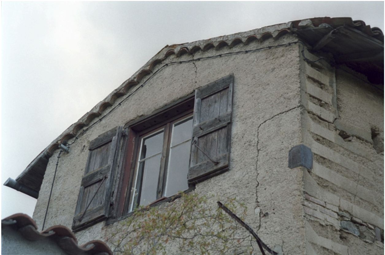
La Font Fort, bâtiment agricole en pisé (1986 B1 391). Détail du mur pignon.
