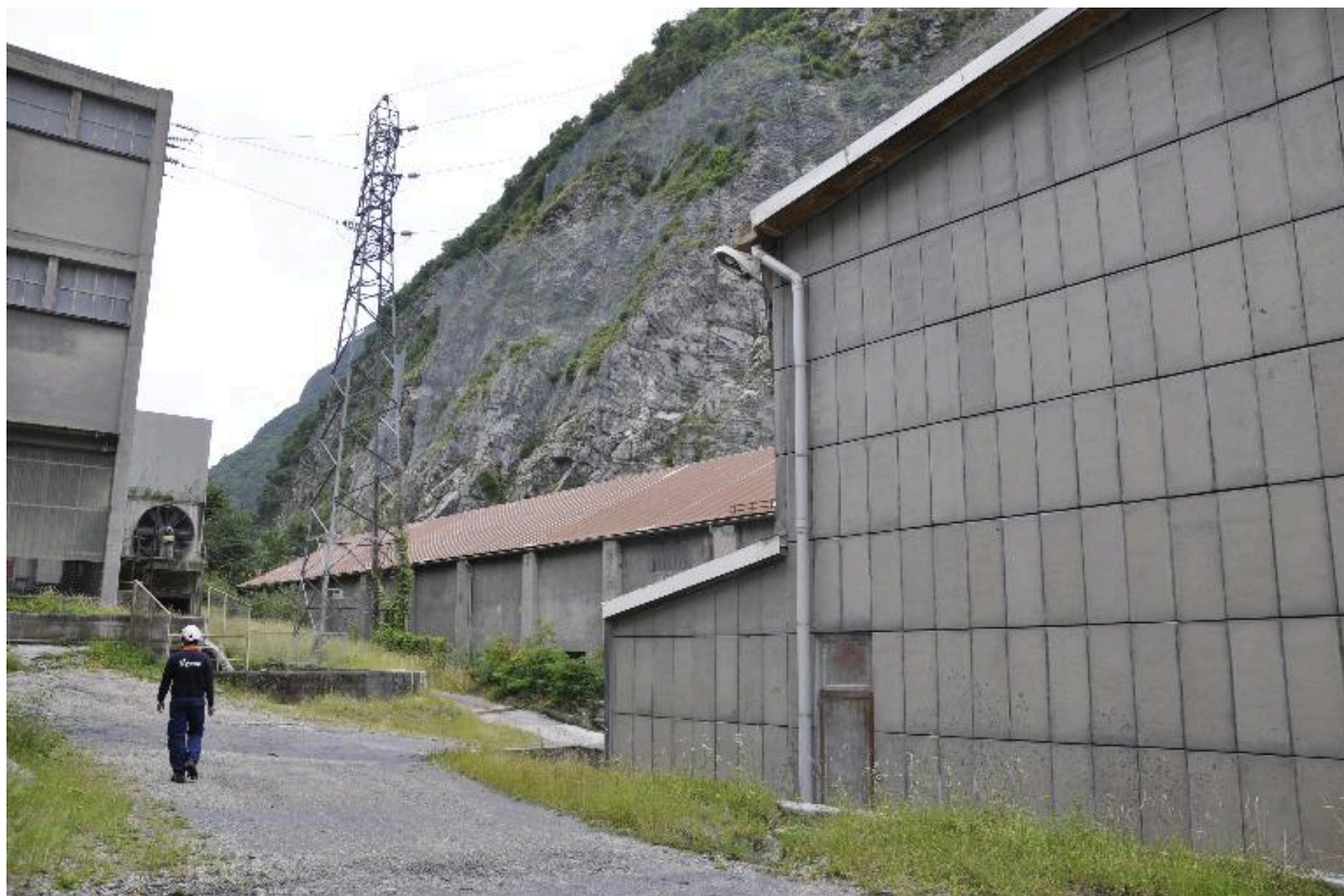
Vue partielle du mur pignon de Pierre-Eybesse III
