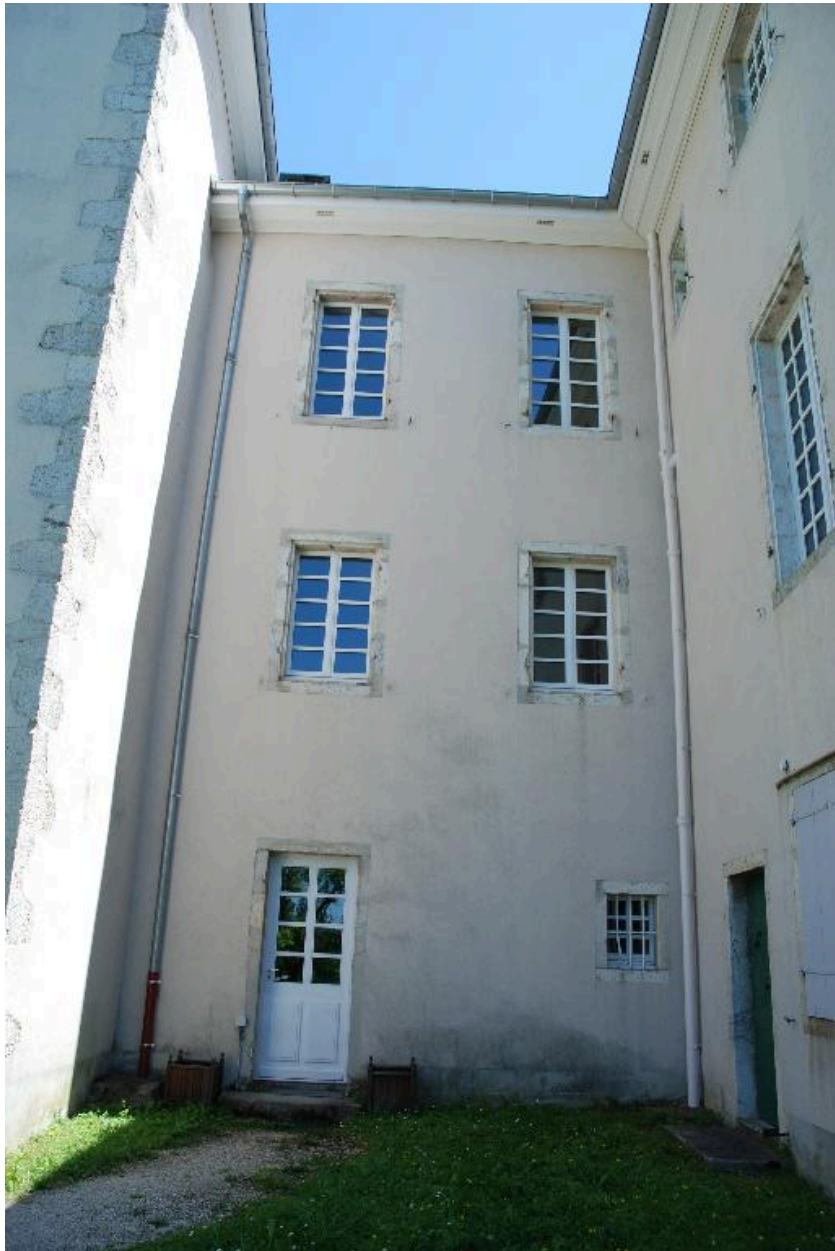
Elévation ouest du corps de bâtiment central où se trouve la cuisine.
