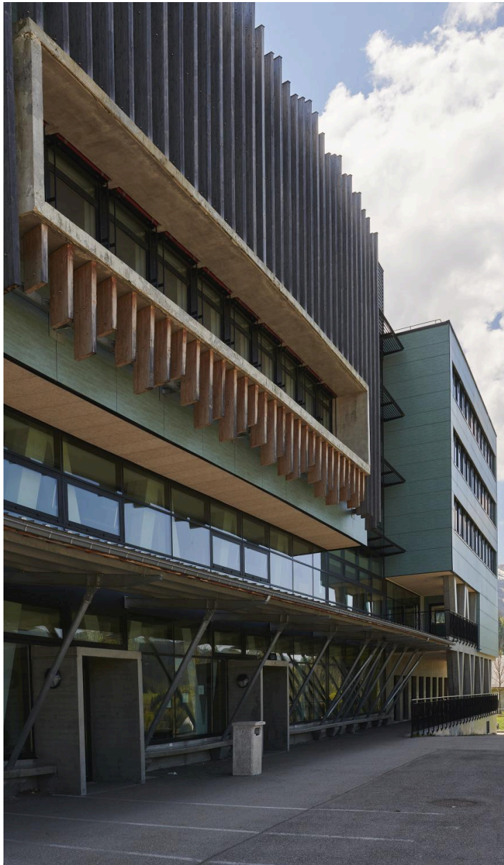
Corps de bâtiment principal : élévation ouest, depuis le nord
