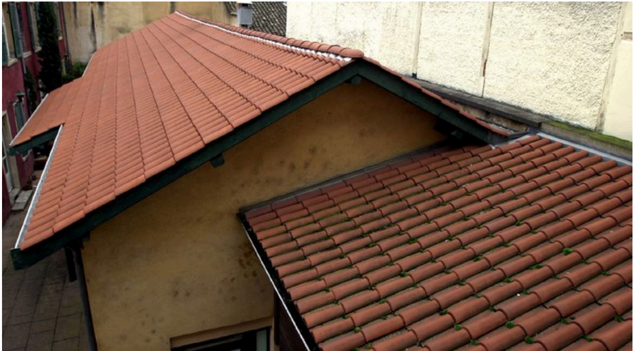
Toitures des dépendances à l'ouest de la cour
