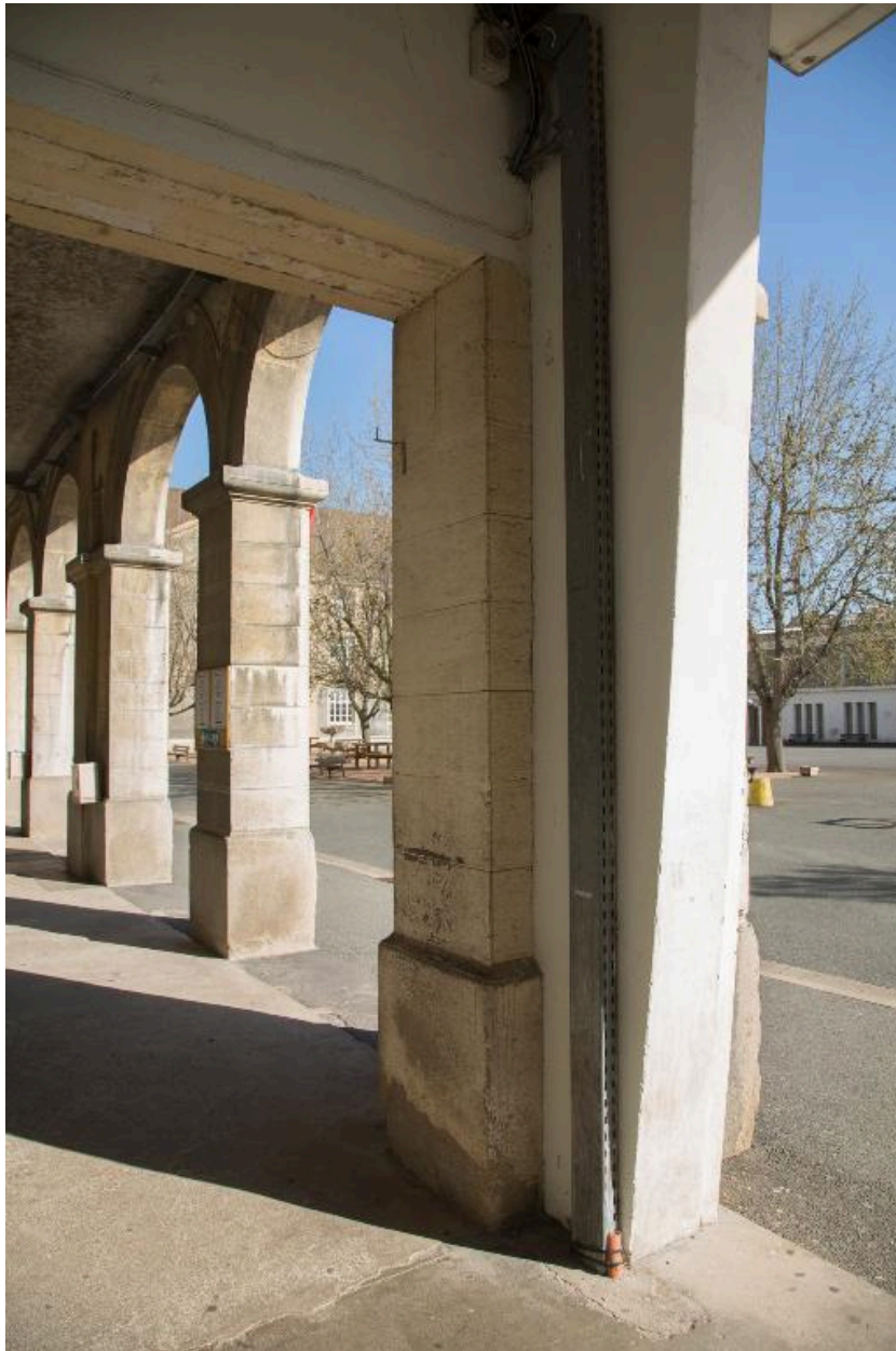
Jonction entre le bâtiment H et le bâtiment B sous la galerie
