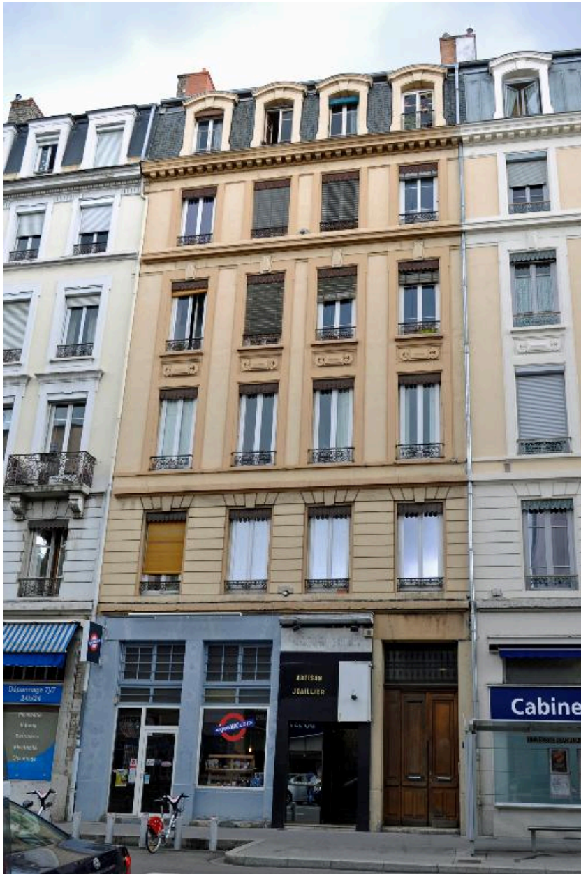
Vue générale, élévation sur rue
