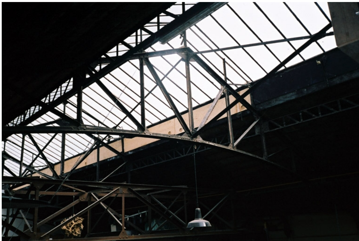
Détail charpente et lanterneau
