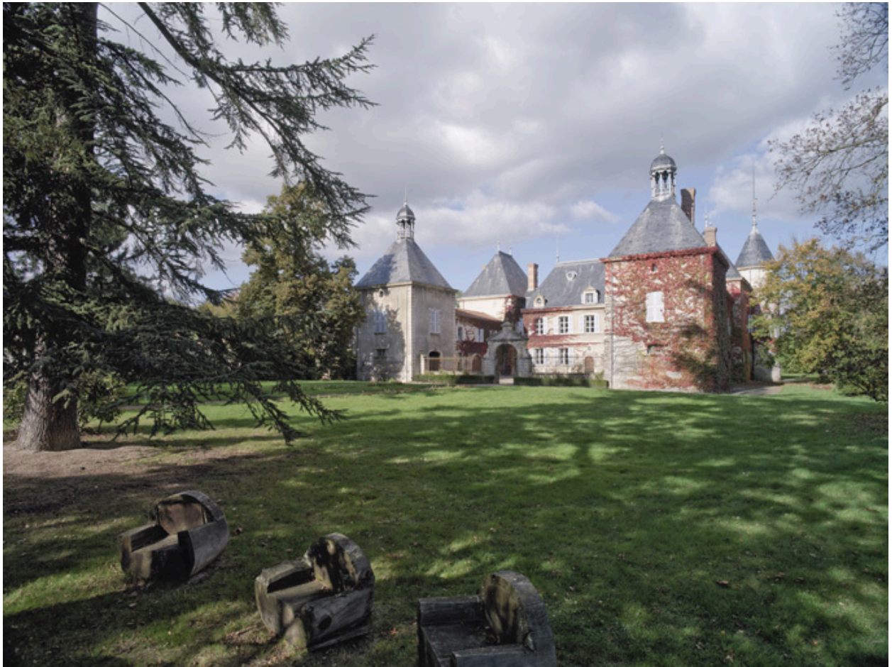
Vue d'ensemble de la partie sud, depuis le sud-est.
