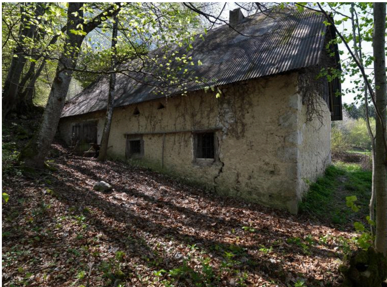
Vue d'ensemble du mur gouttereau nord-est.
