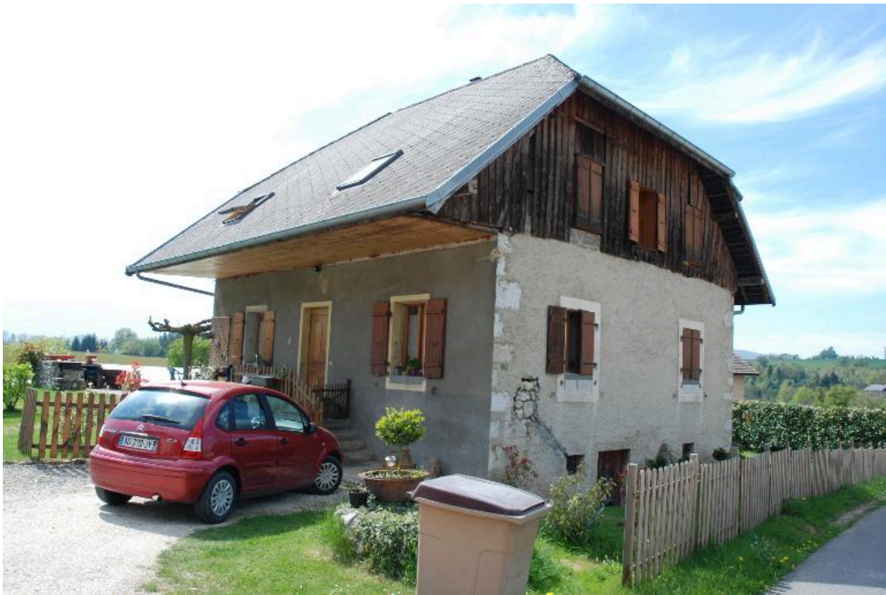
Vue d'ensemble de trois-quarts avant droit du nouveau logis.
