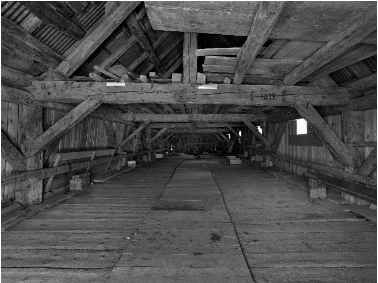
Vue intérieure de l'étable.
