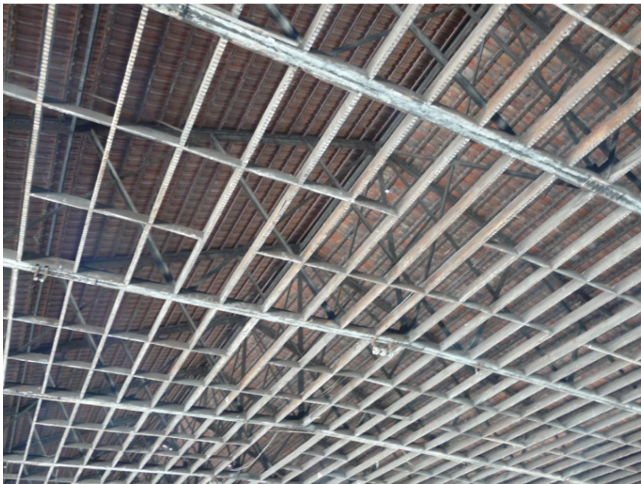
Détail charpente de la grande halle n° 76
