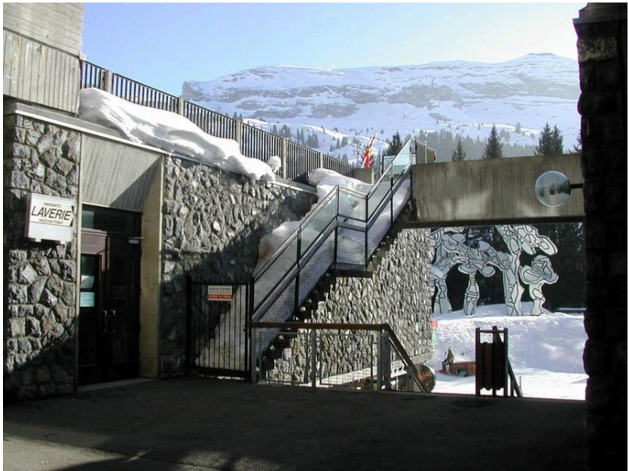
L'escalier d'accès à la terrasse
