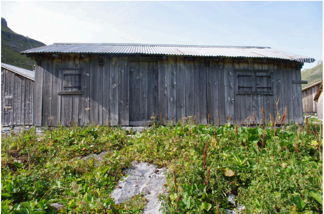
Vue de la façade antérieure sud
