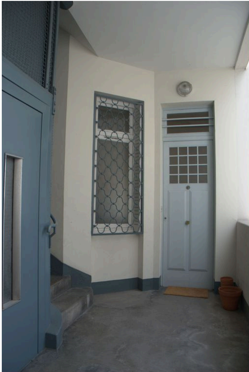
Palier de l'escalier de service, porte palière et fenêtre, depuis l'ouest
