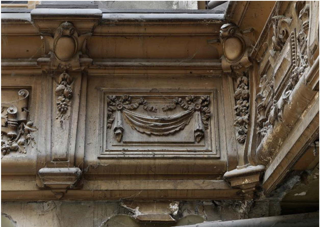
Cour, galerie du 1er niveau, détail d'un panneau
