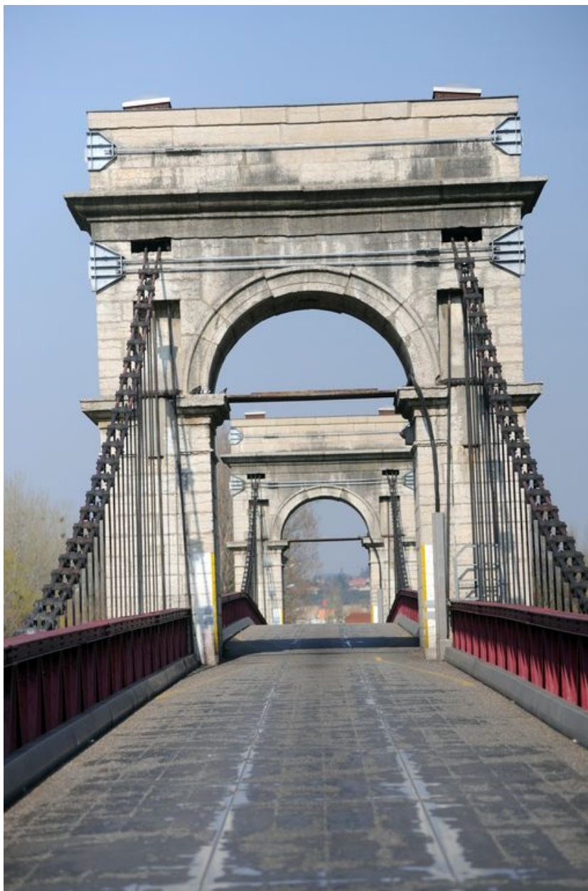
Piles, de dessus, vue générale (depuis la rive droite)
