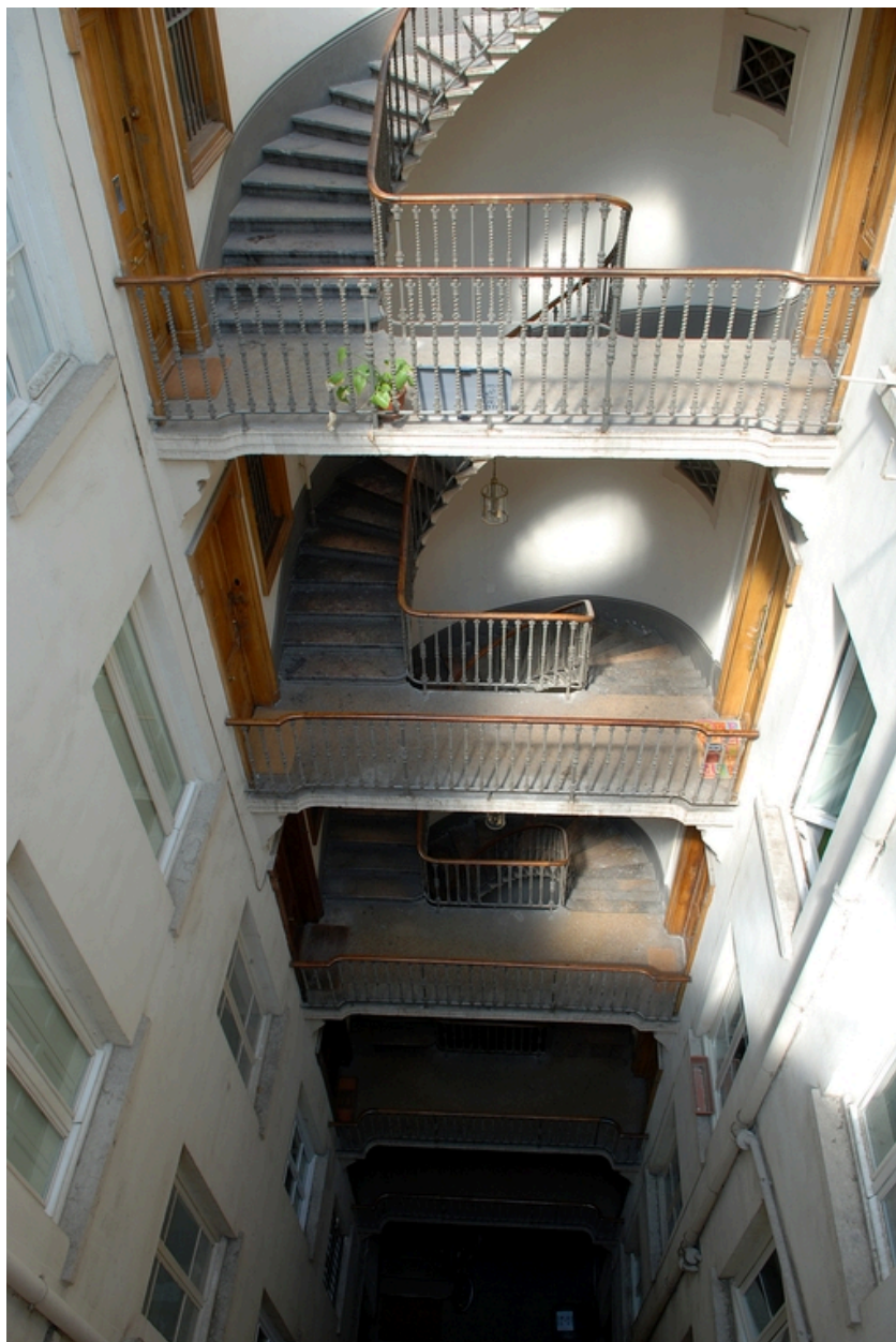
Escalier est : vue en plongée
