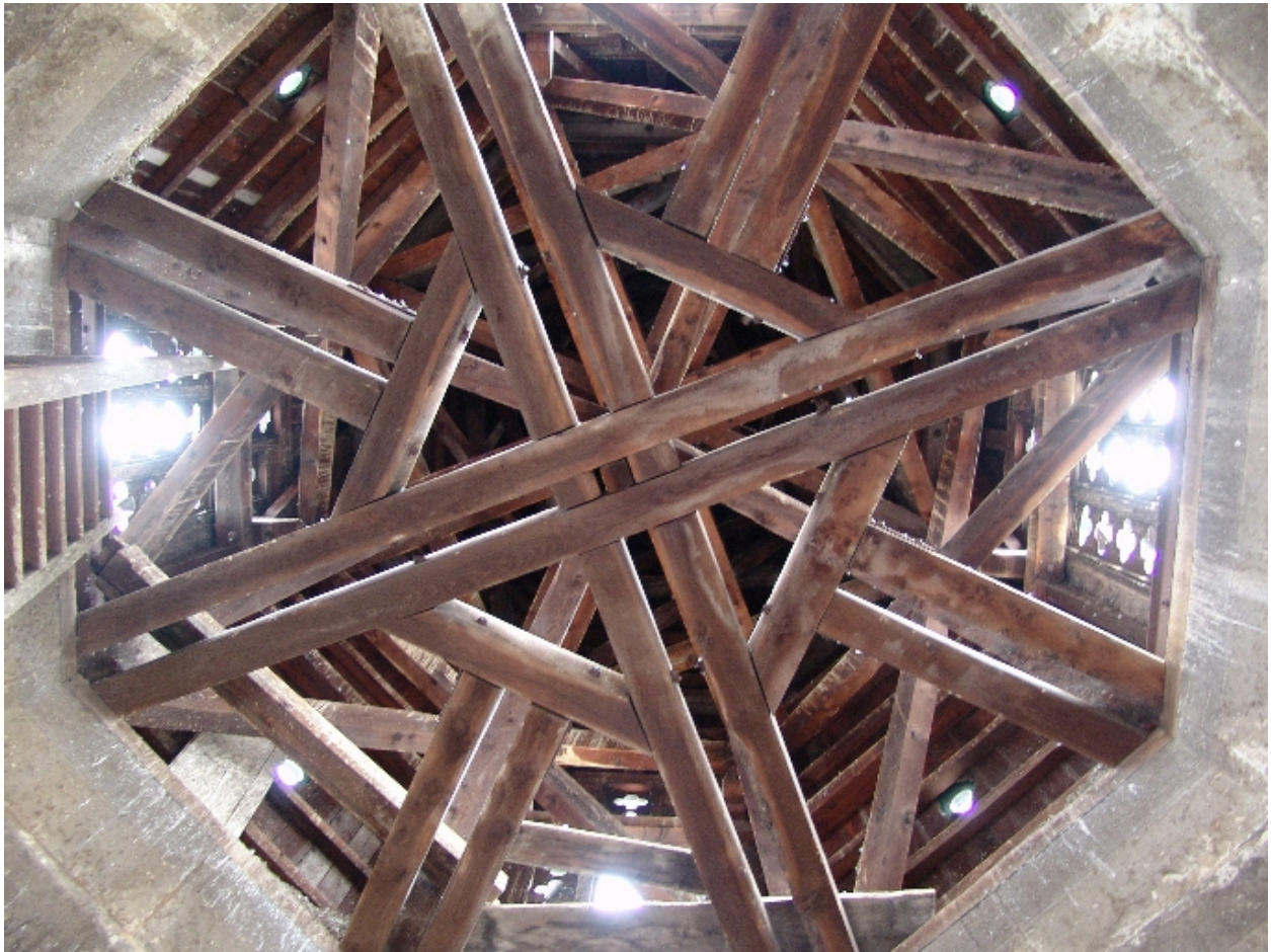
Charpente de la flèche
