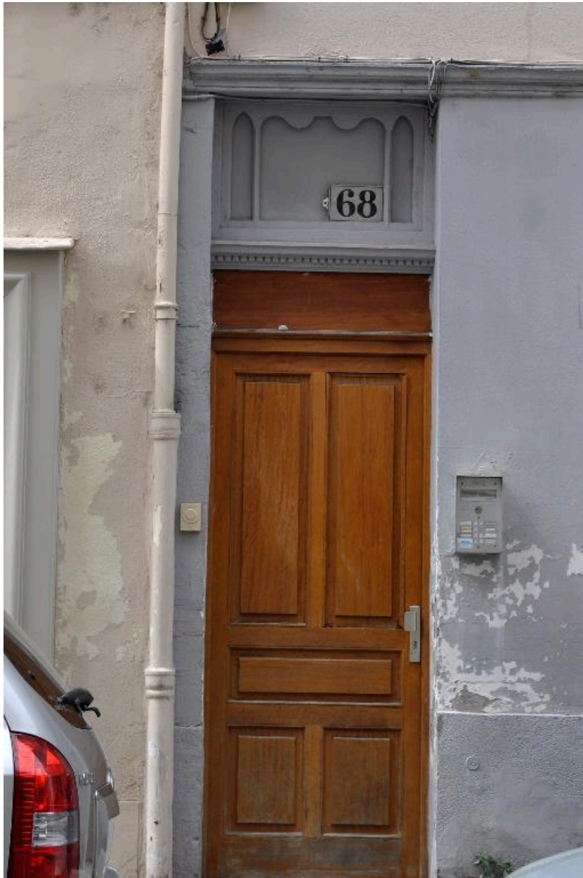
Vue rapprochée de la porte, imposte à colonnettes bois
