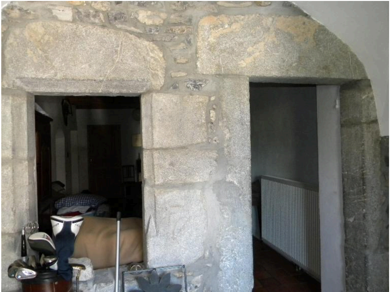
Anciens encadrements de porte et fenêtre de logis en partie intérieur du bâtiment.
