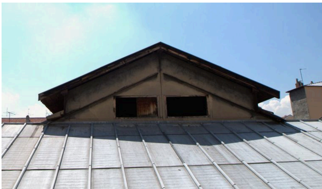
Vue du comble de la salle de cinéma, depuis le nord
