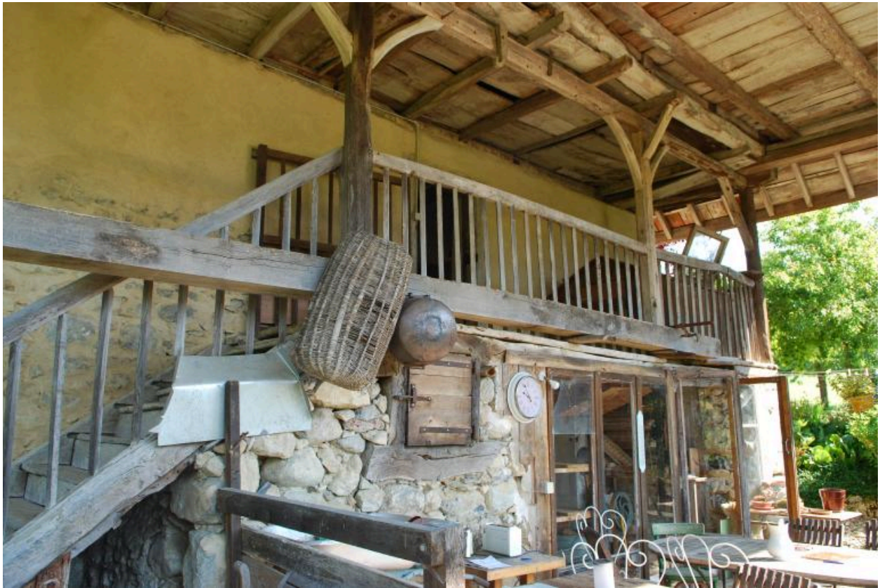
Bâtiment principal, pignon nord-est.
