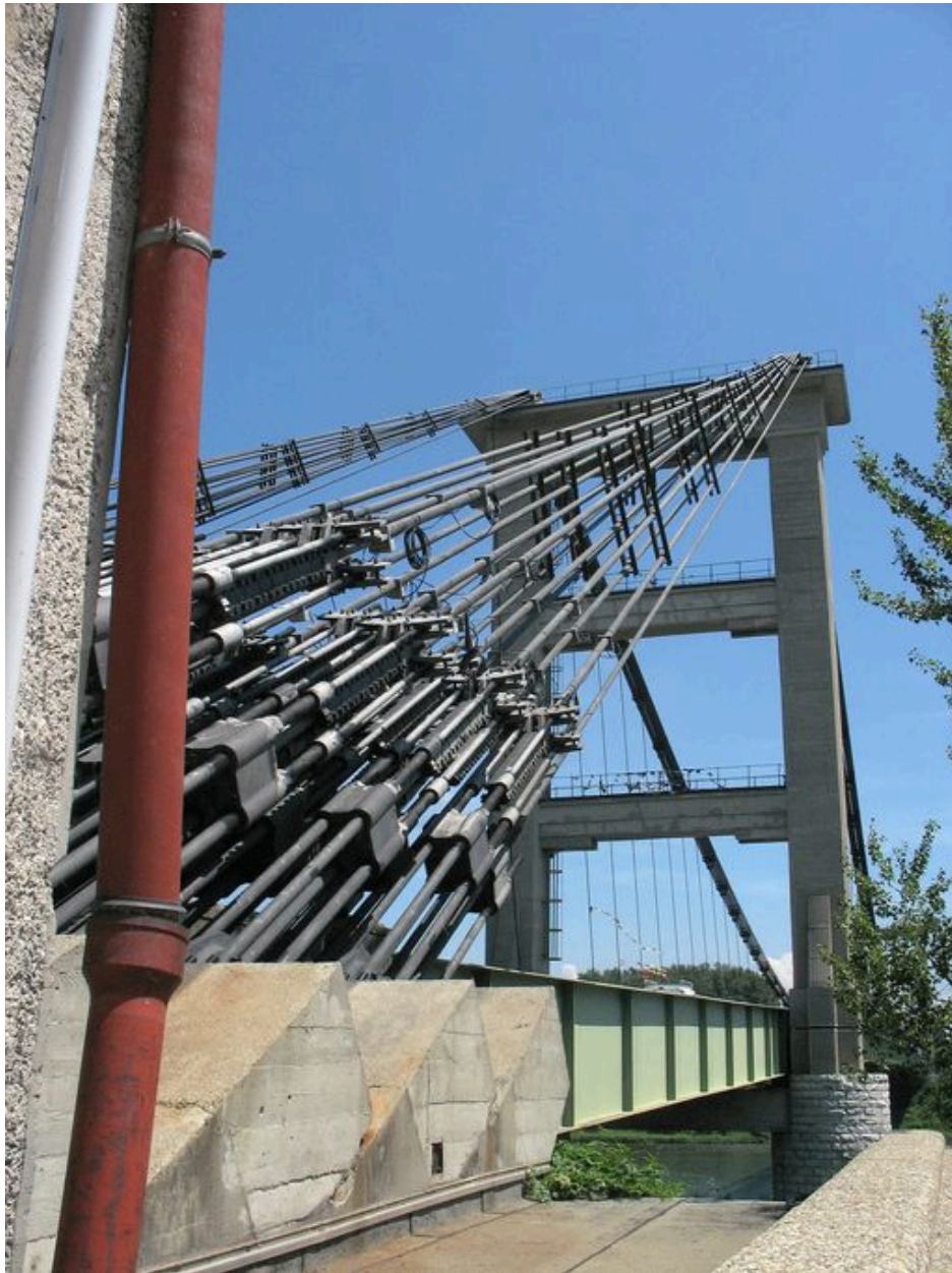
Pylône rive droite et câbles d'ancrage (côté aval)
