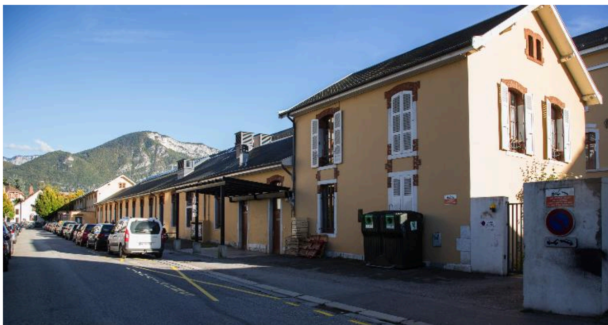
Façades sur boulevard Nicolle.
