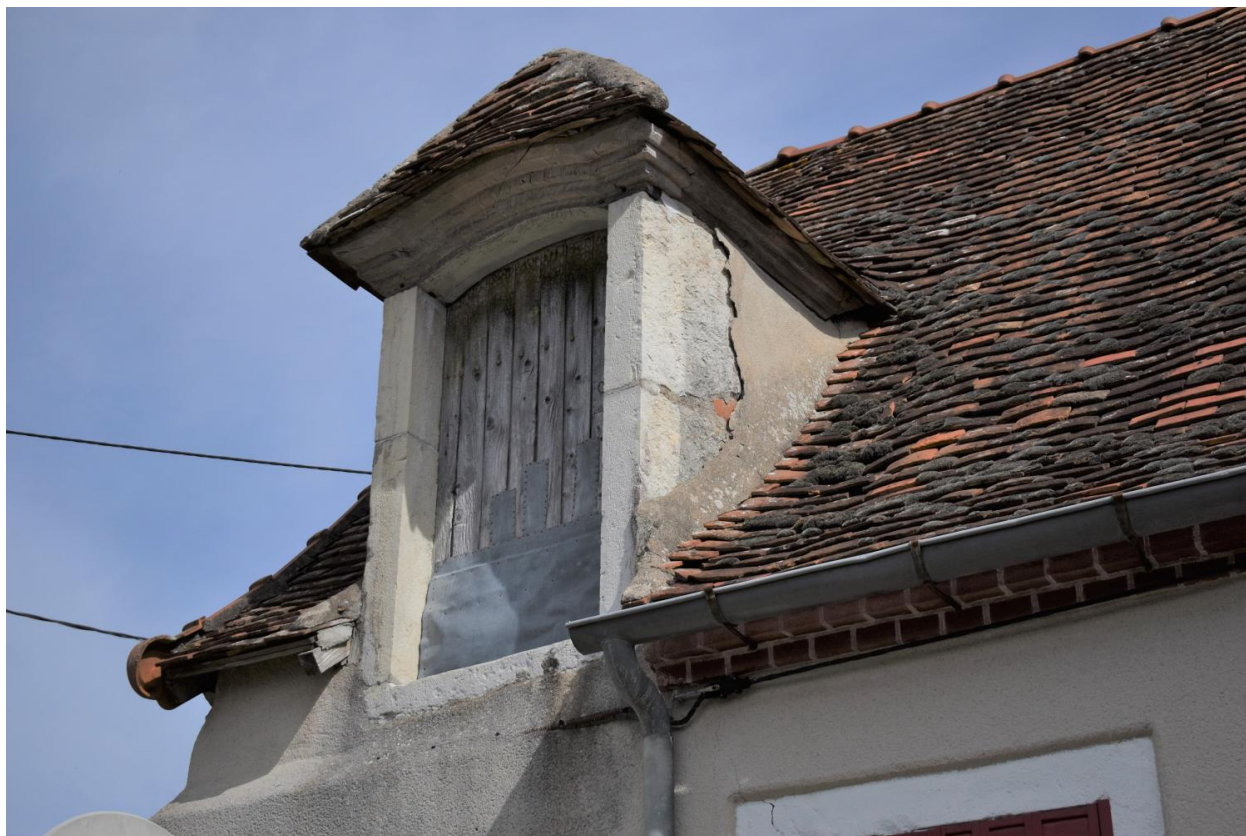
Lucarne à la capucine à encadrement de pierre, linteau cintré et corniche de bois cintrée. Antérieure au cadastre dit napoléonien. (A4 712).
