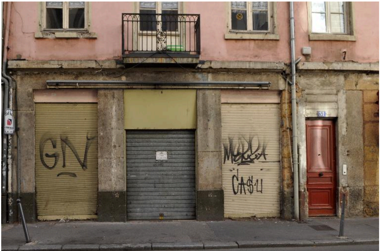
Elévation sur rue, vue du rez-de-chaussée
