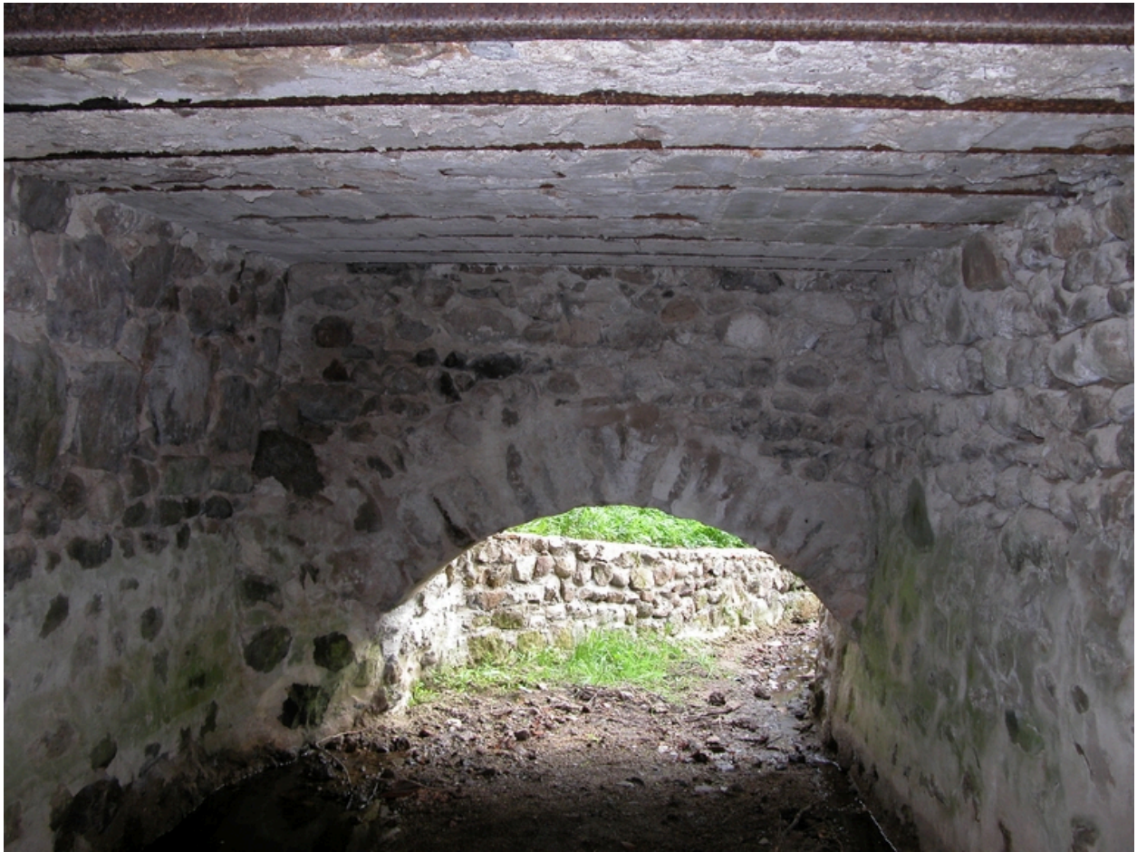
Vue du passage du bief.
