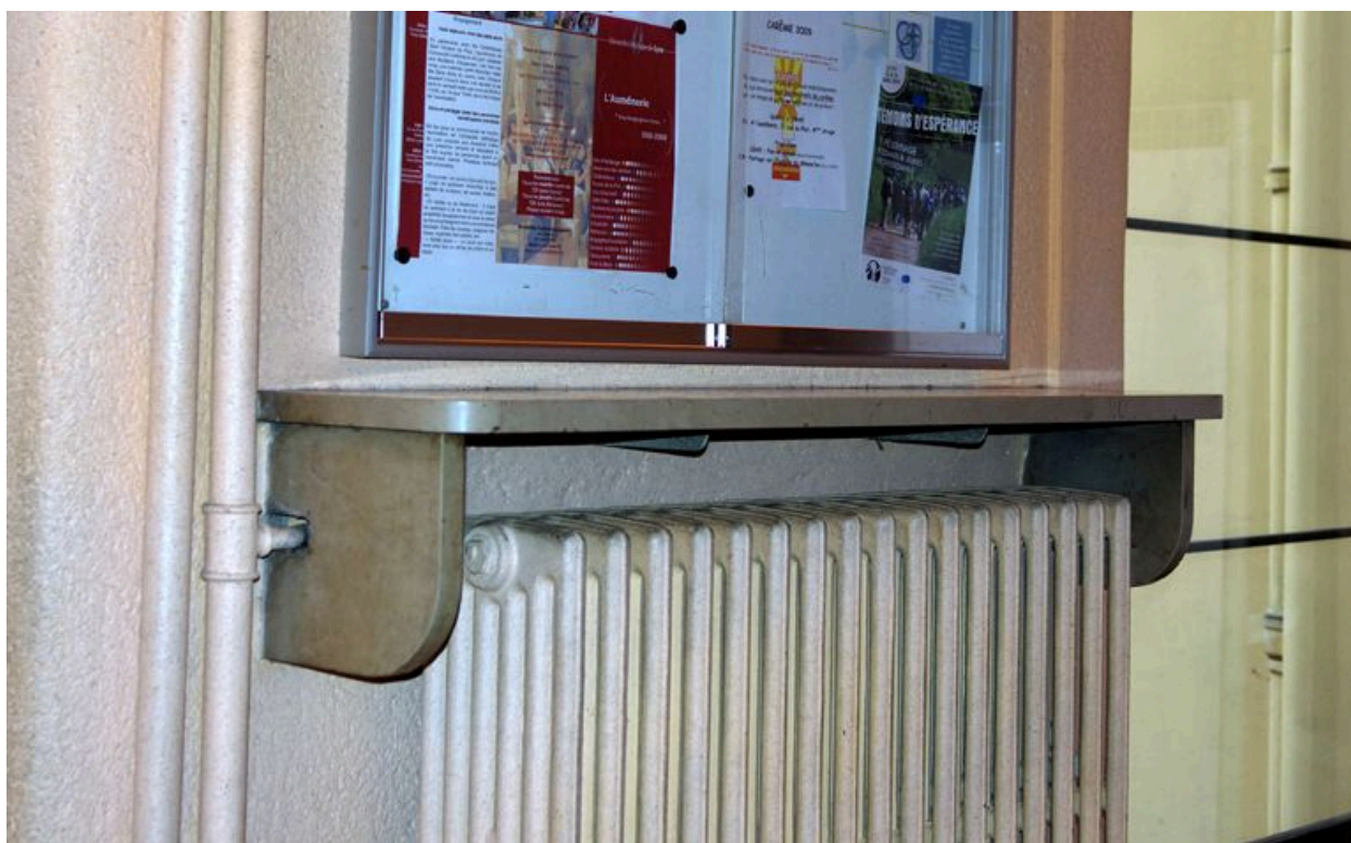
Hall principal, dessus de radiateurs.
