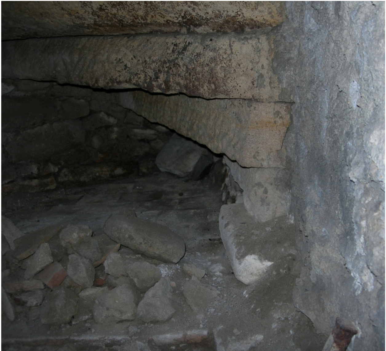
Départ de l'escalier, vue par dessous.
