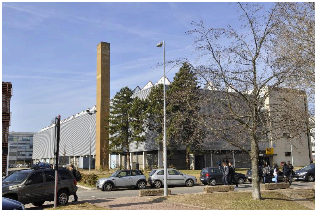
Vue de l'ensemble de la halle
