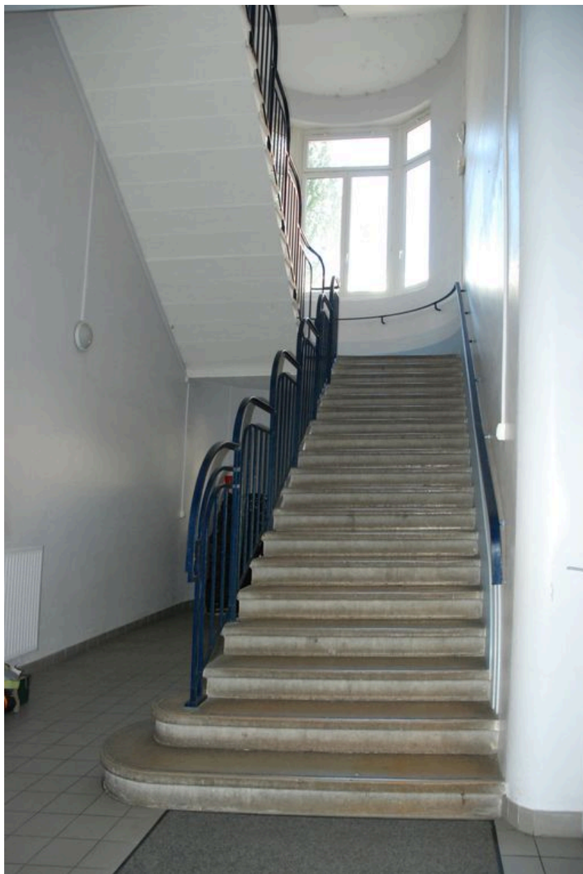
Vue sur l'escalier central du rez-de-chaussée
