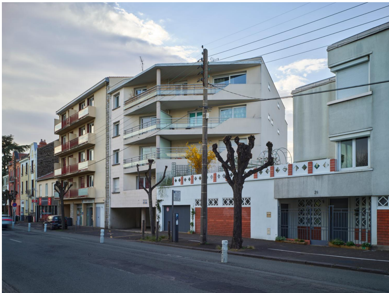
Façade sur le boulevard Jean-Jaurès
