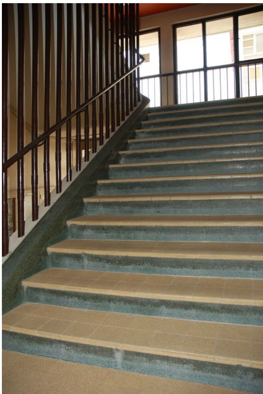
Escalier sud menant à l'ancien restaurant du personnel
