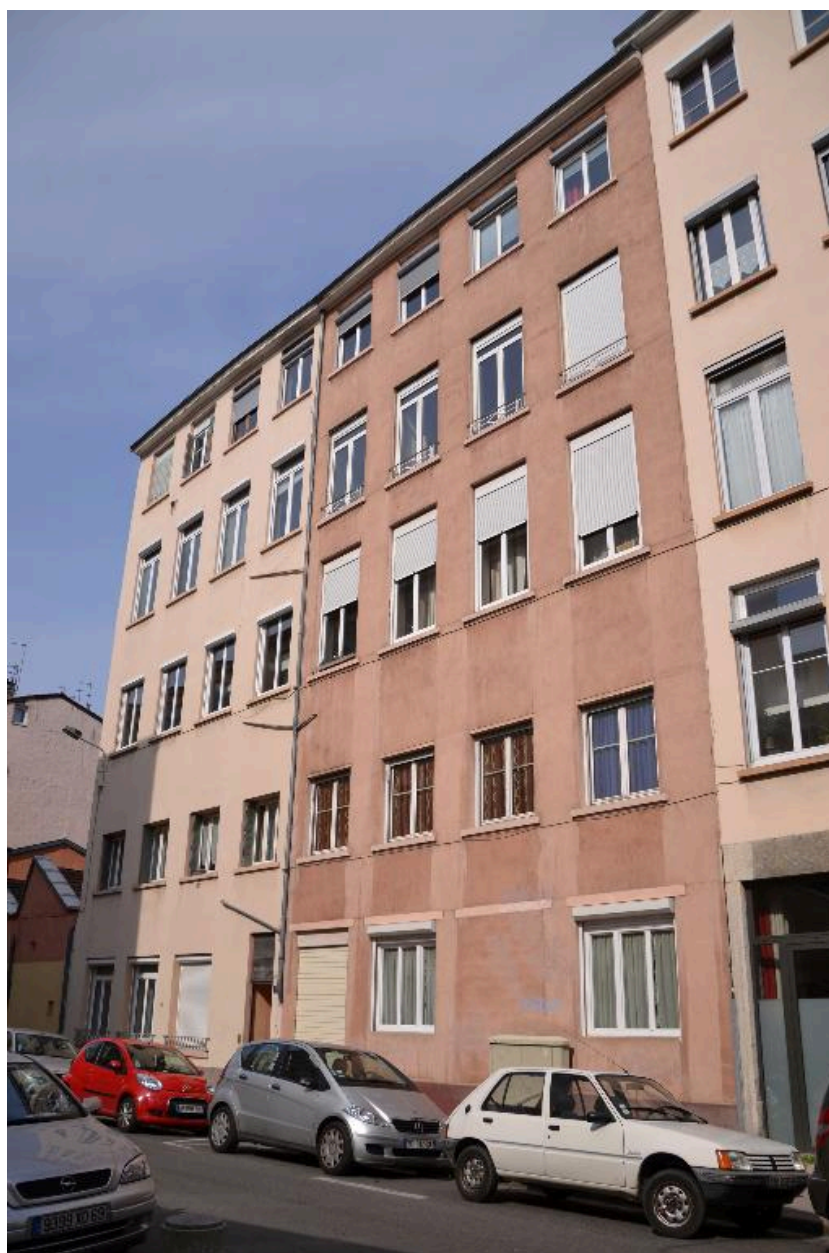
Vue d'ensemble façade sud
