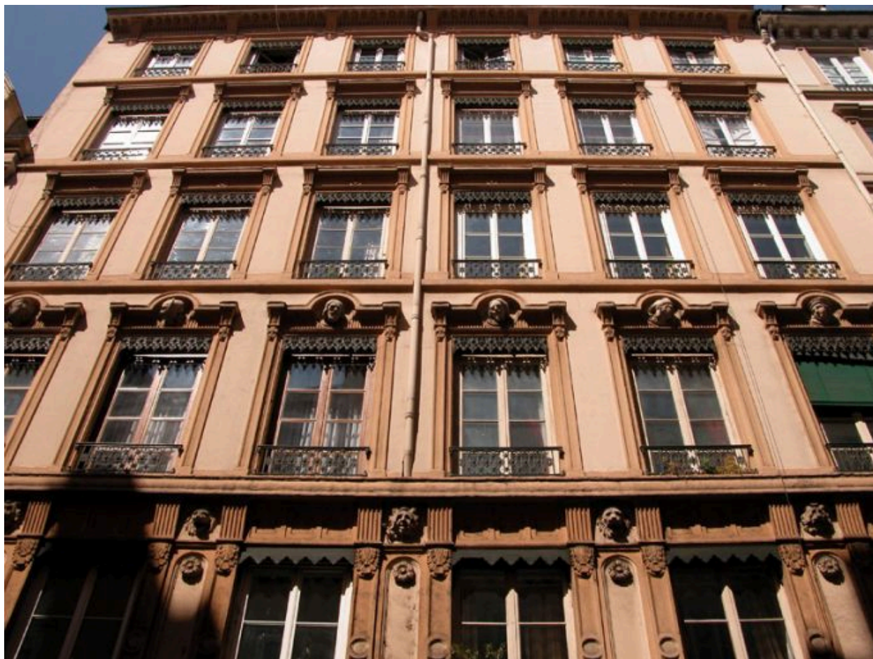
Bâtiment 1, façade sur la rue Lanterne
