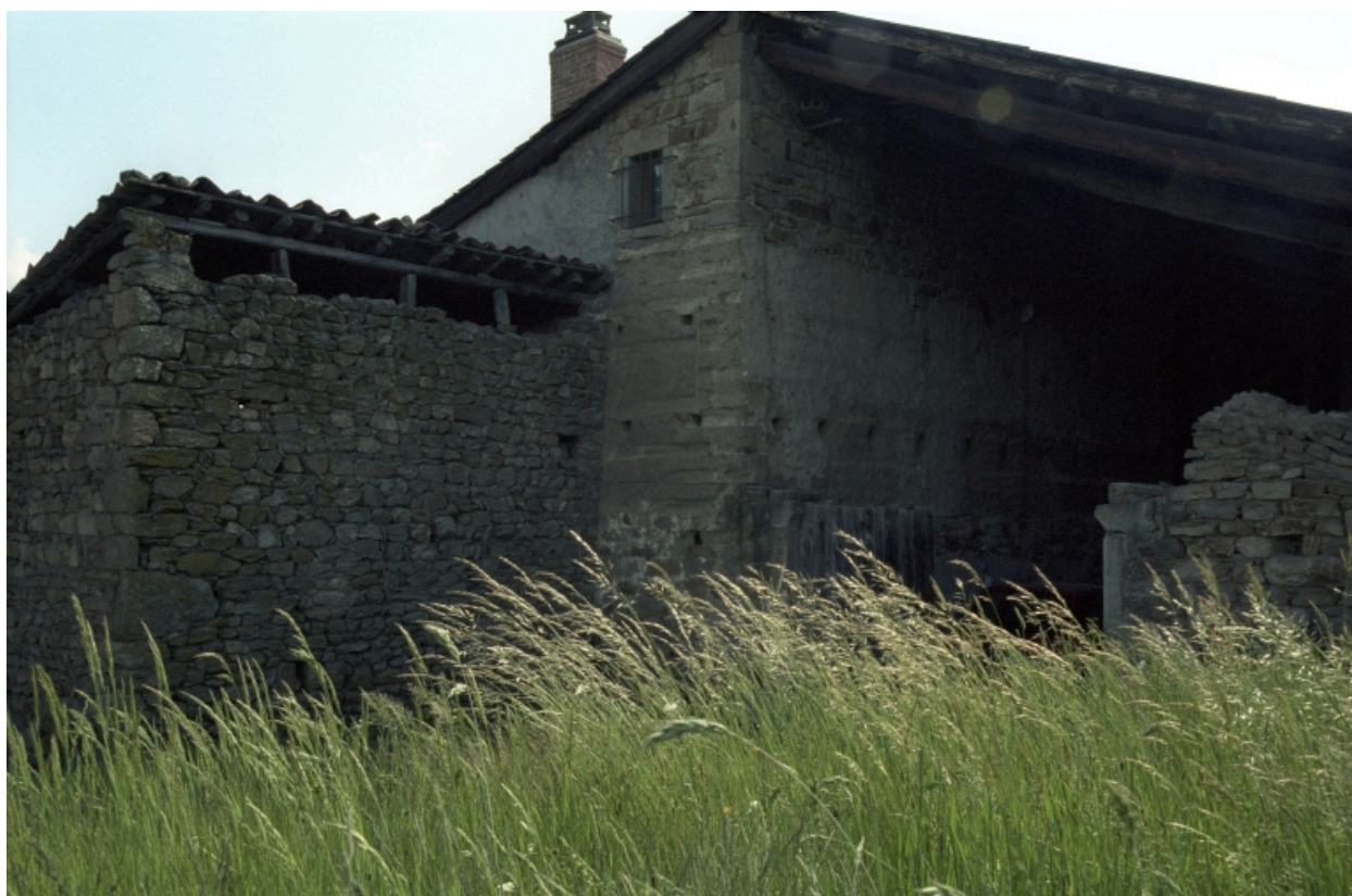
Marcilly-le-Châtel, Maure (1987 A4 1337, 1339), type A2. Détail des matériaux sous le hangar, à l'arrière du logis.
