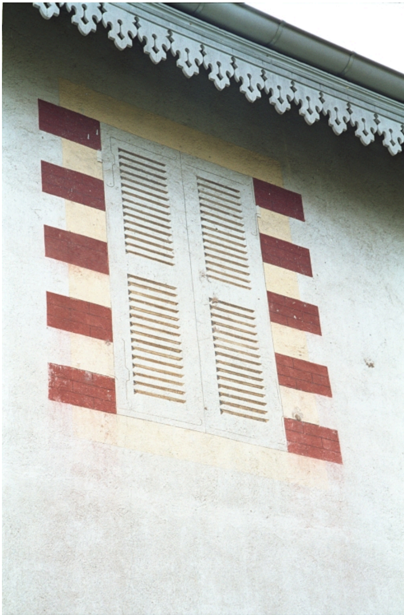
Elévation partielle de la façade sur jardin, côté droit, détail de baie en trompe-l'oeil.
