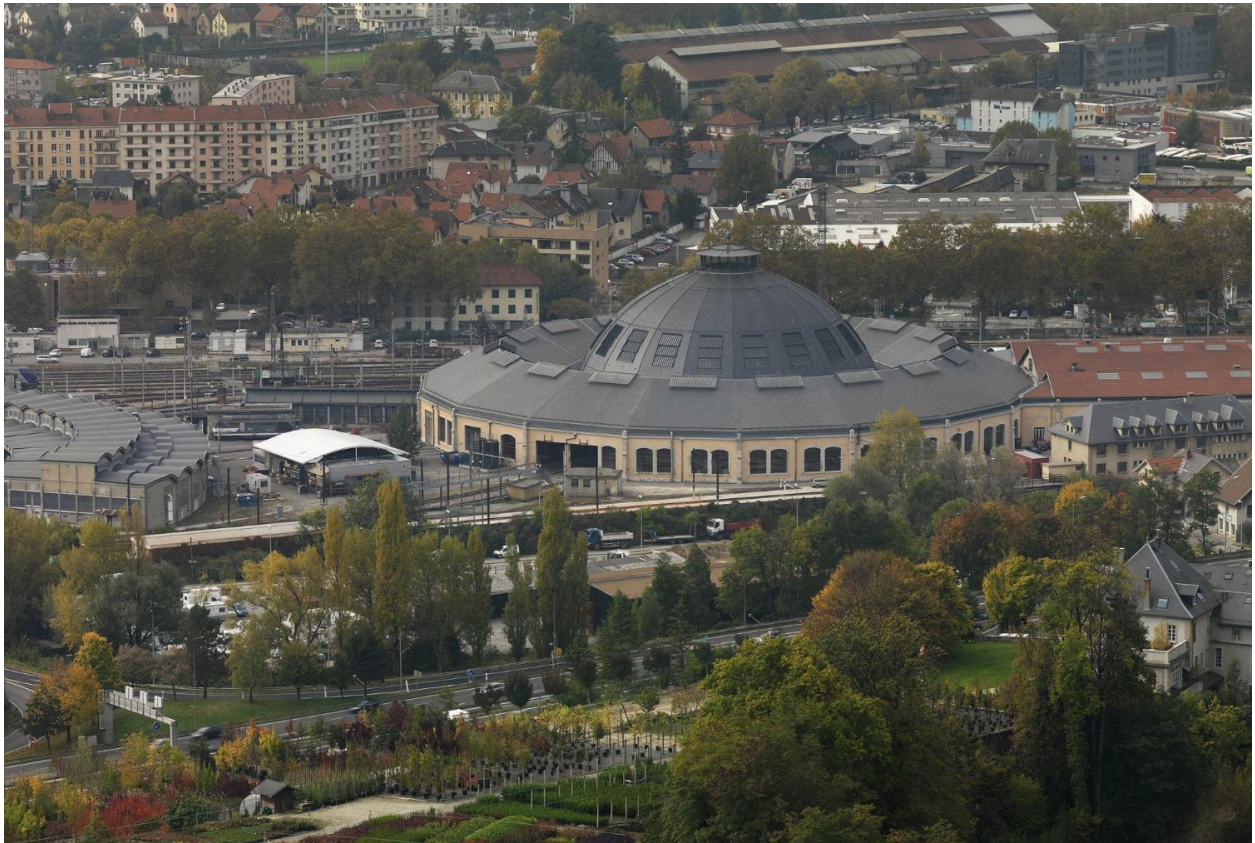
Détail coupole : rotonde de Chambéry
