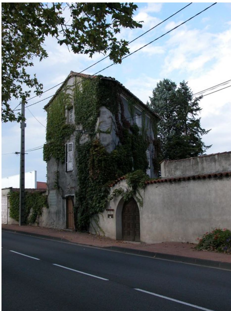
Cuvage transformé en habitation (?) (Montbrison, Moingt, les Purelles, 1986 AK 53).
