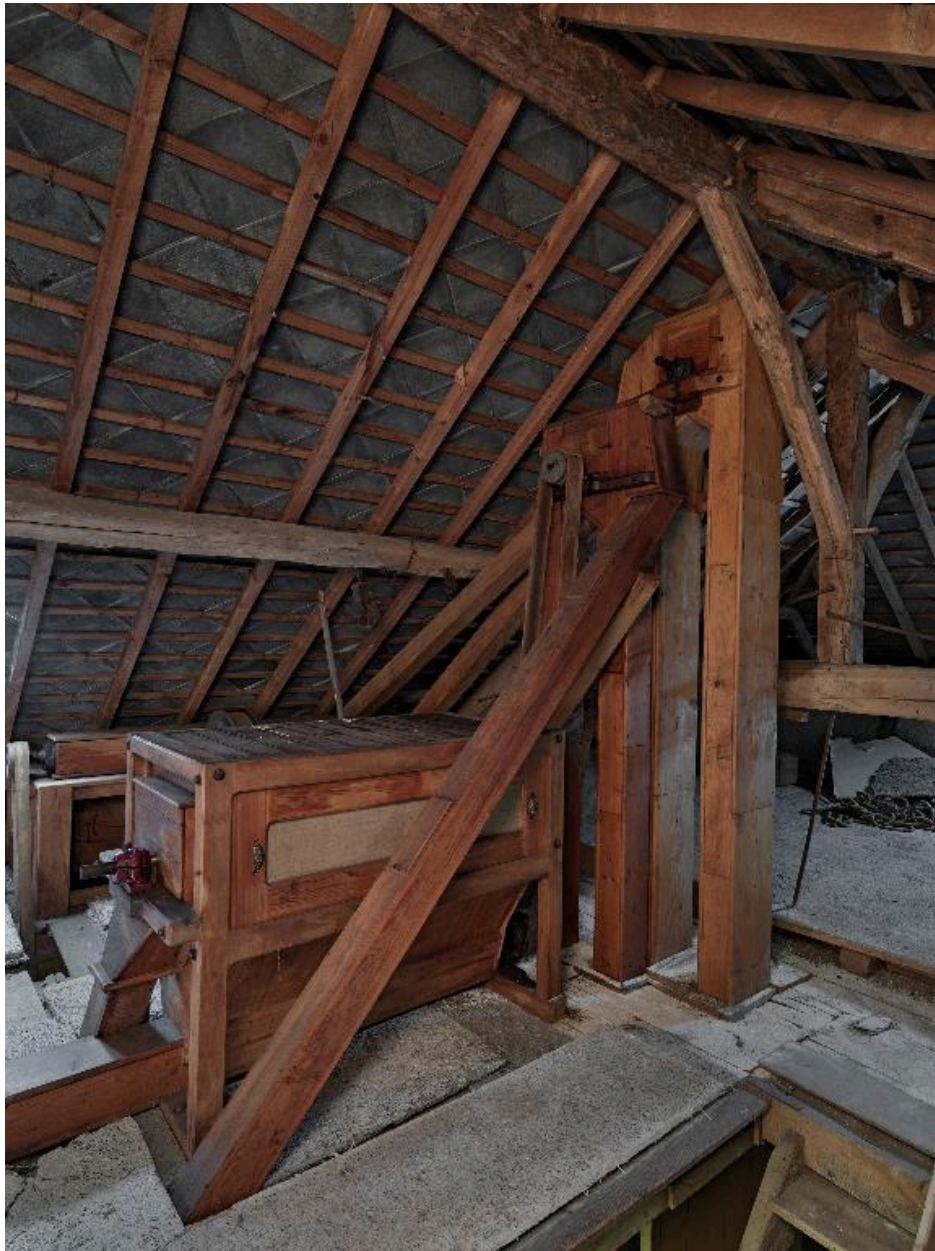
Etage de comble : trieuse de son et ascenseur.
