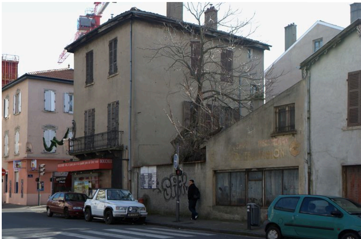
Vue générale depuis le nord-ouest
