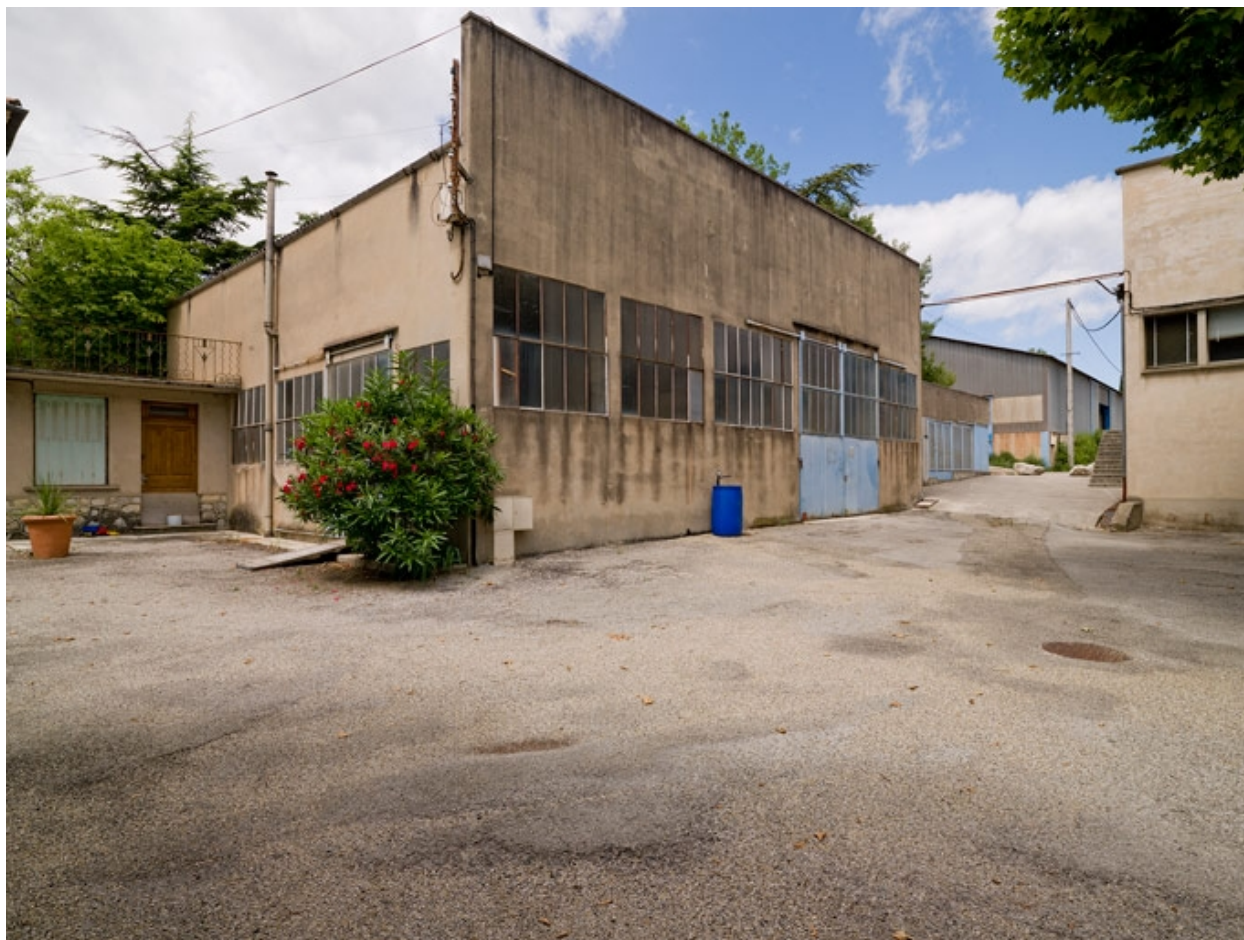
Vue d'ensemble est
