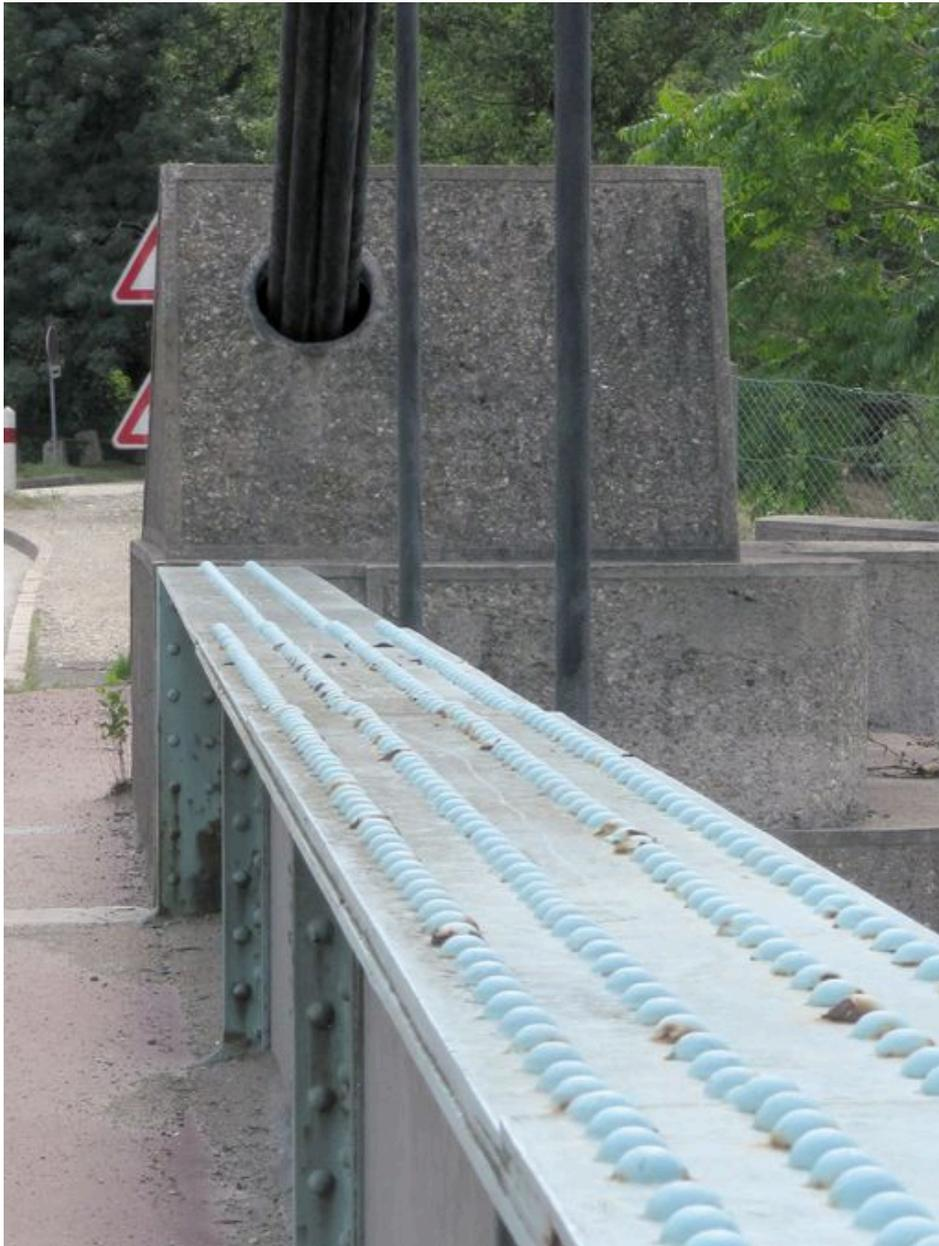
Massif d'ancrage gauche, vue de détail : jonction avec le câble porteur (depuis la rive gauche)
