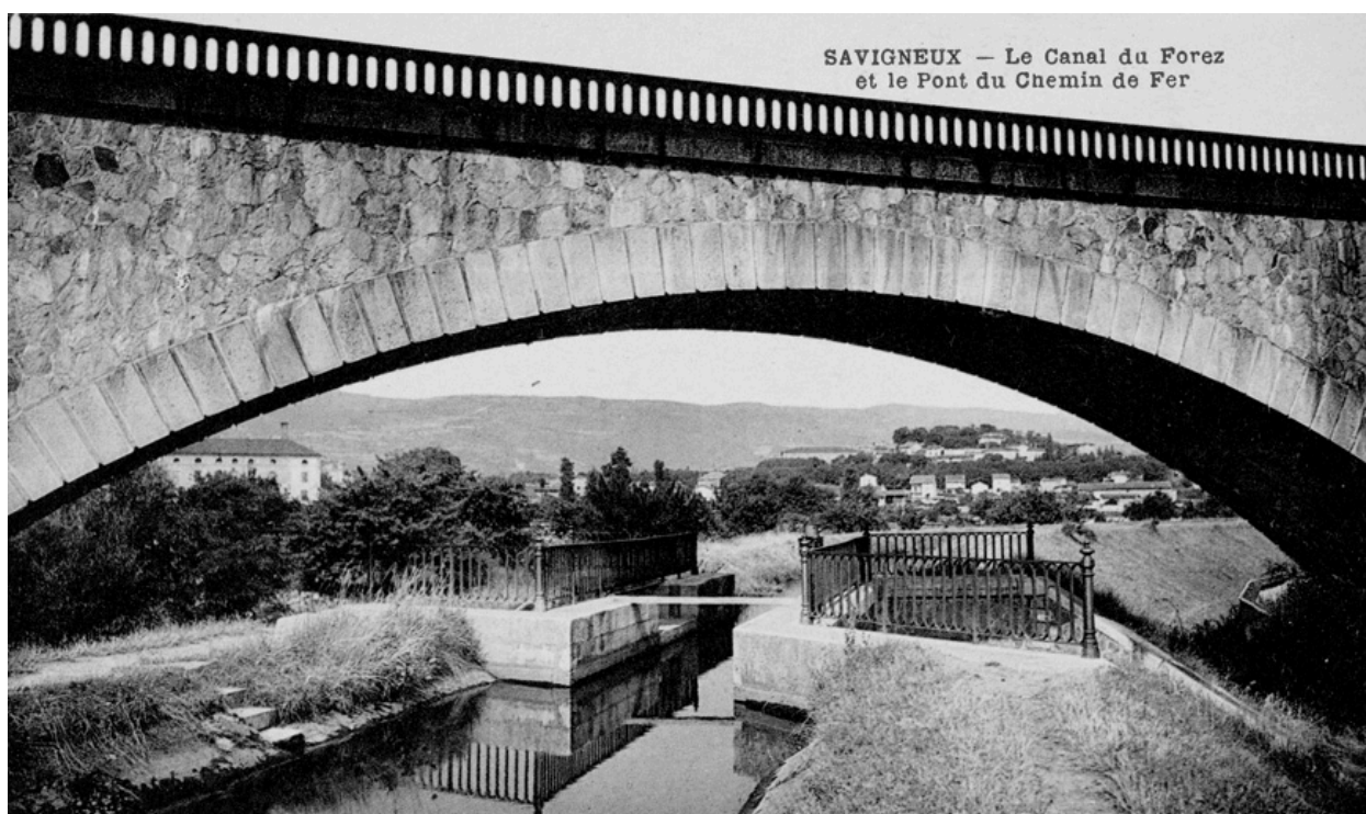
SAVIGNEUX - Le Canal du Forez et le Pont du Chemin de fer. Cliché Dubost.
