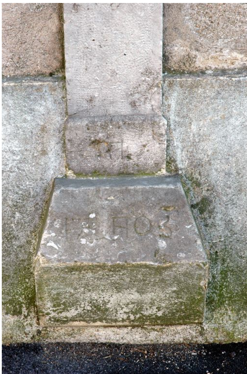
Détail de la base de la croix
